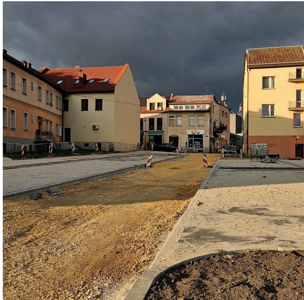
Budowany łącznik między Krakowską a 29 Listopada w Chrzanowie. W głębi widok na ul. Krakowską.
