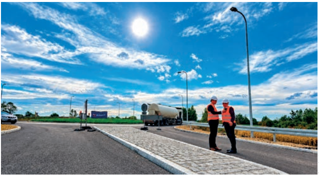
Budowa obwodnicy Olszyn i Jankowic dobiega końca
