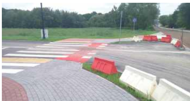
Tak obecnie wygląda skrzyżowanie ulicy Józefa Geresza z remontowaną ulicą Janusza Kusocińskiego
