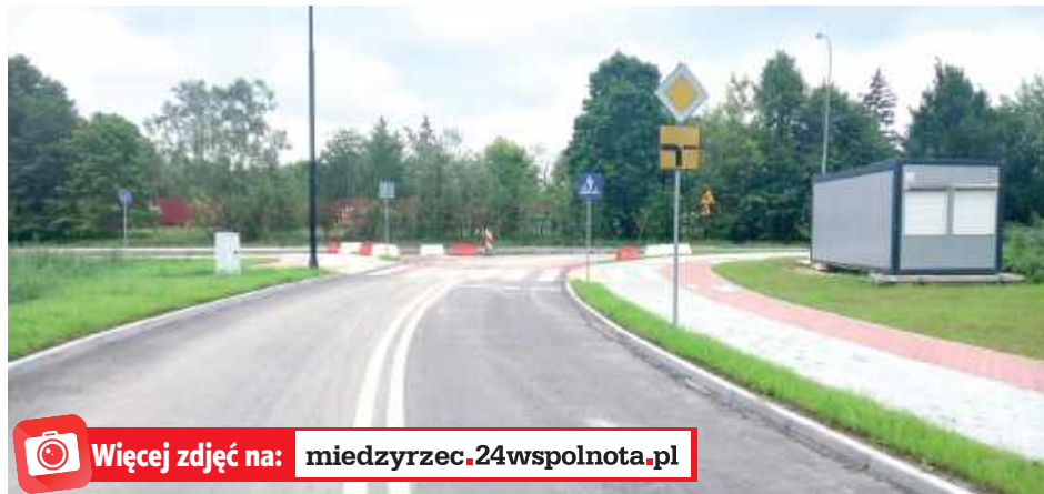
Widok na skrzyżowanie ulicy Józefa Geresza z remontowaną ulicą Janusza Kusocińskiego
