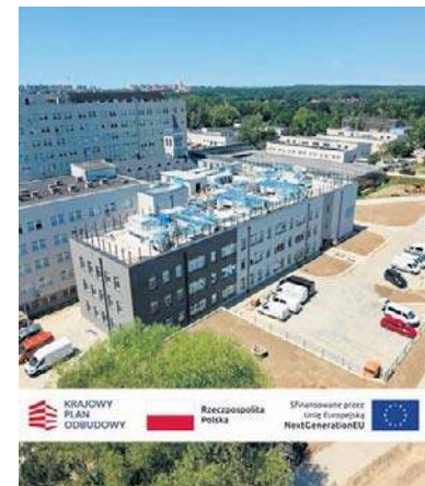
Nowoczesny sprzęt czeka na montaż i uruchomienie
