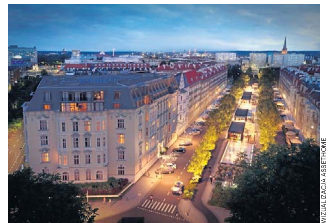
Tak ma wyglądać kamienica po przebudowie, pod obiektem powstanie garażowiec
