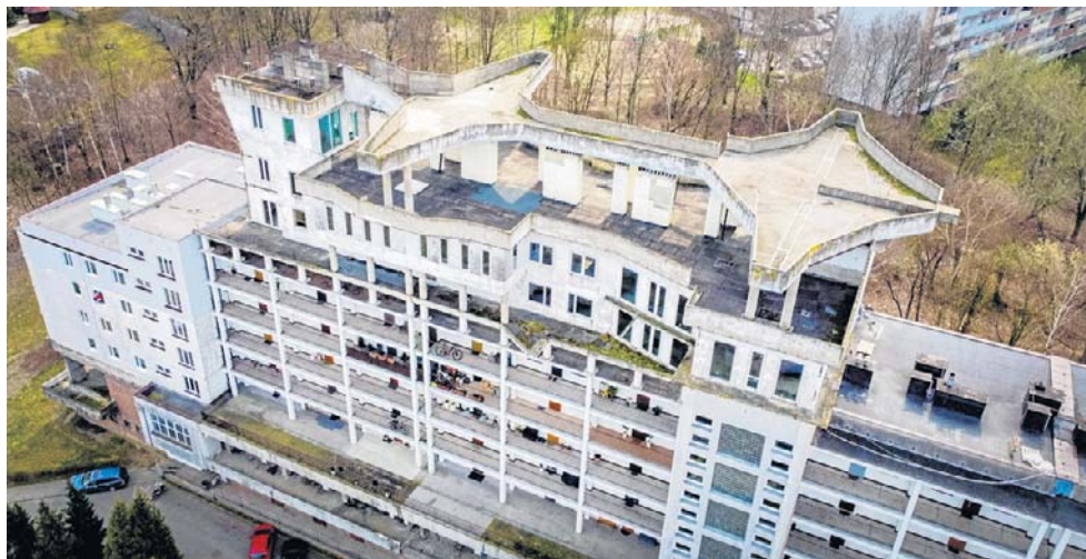
Część nadbudowy została już rozebrana
