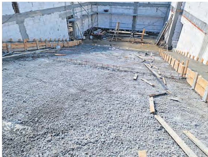
Aktualny widok z ostatnich, przyszłych rzędów krzesełek. Fot. UM Tuchola
