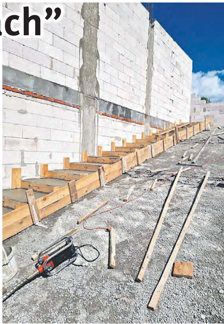
Są już też schody. Fot. UM Tuchola
