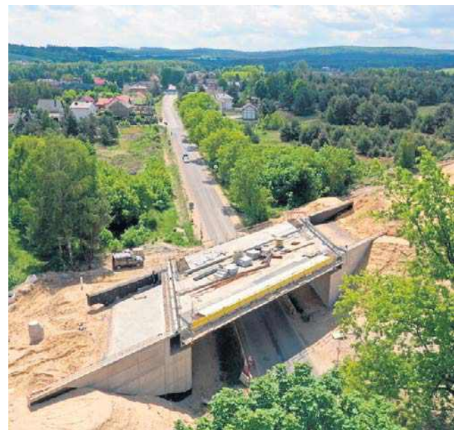
Budowlancy nie mają wakacji, tempo pracy imponuje
