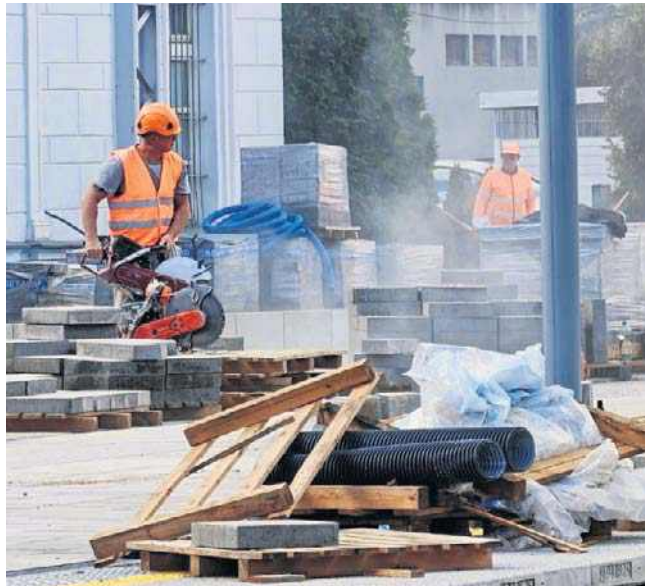
Prace modernizacyjne peronów 1 i 2 w Sosnowcu potrwać do początku 2027 roku
