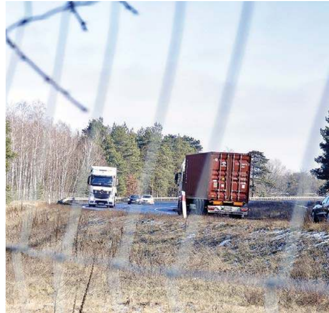
Trasa S10 w miejscu oddalonym o około 300 metrów od ulicy Poznańskiej - tu mają stanąć ekrany akustyczne
