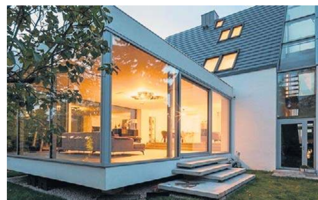
Dobudowany salon zapewnia panoramiczny widok na okolicę. Z prawej - nowa klatka schodowa
