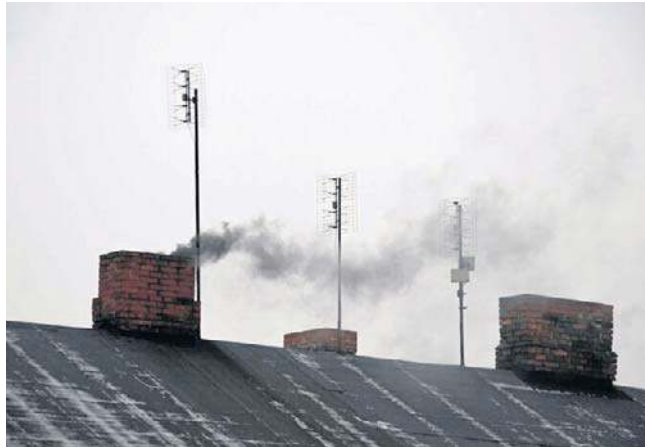
Wymiana pieca nie kosztuje lokatora ani grosza. Warto porozmawiać z pracownikami ZZK
