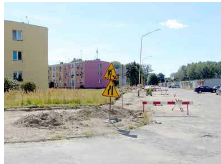
Miejsce robót ponownie zostało oznakowane
