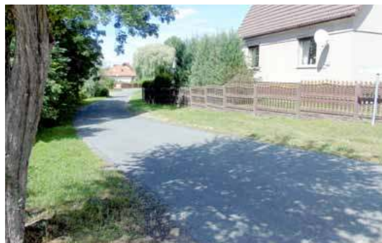
W ostatnim czasie naprawiona została również nawierzchnia drogi na ulicy Sikorskiego
