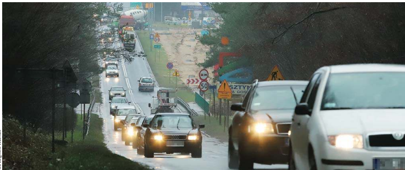
Pod hasłem północnej obwodnicy kryją się: budowa północnej obwodnicy Olsztyna, obwodnica Dywity oraz przebudowa drogi 51 przez Las Miejski (od mostu na Wadąg)
