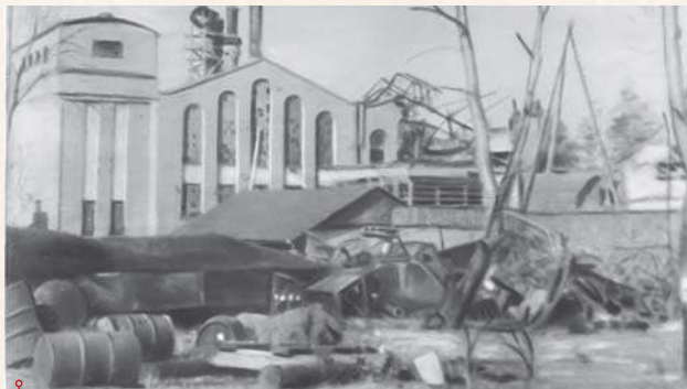
Widok zniszczonej elektrowni
