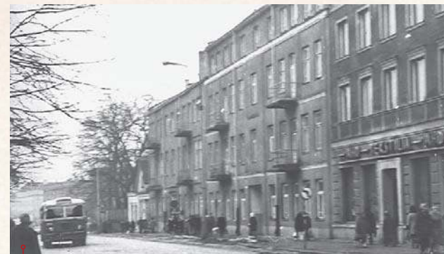
Odbudowane budynki mieszkalne przy ul. Lipowej
