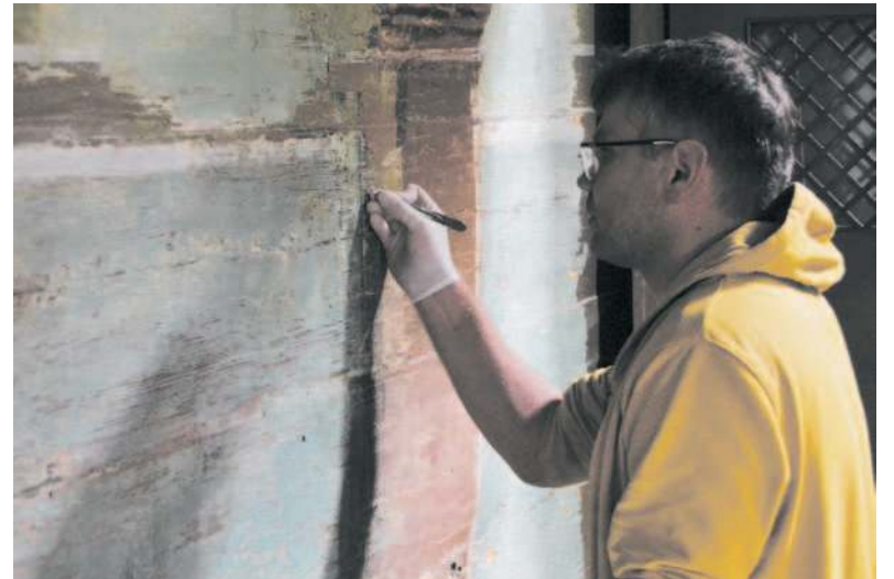
Obecnie w kościele w Dąbrówce trwają prace przy odnowieniu polichromii w nawie głównej
