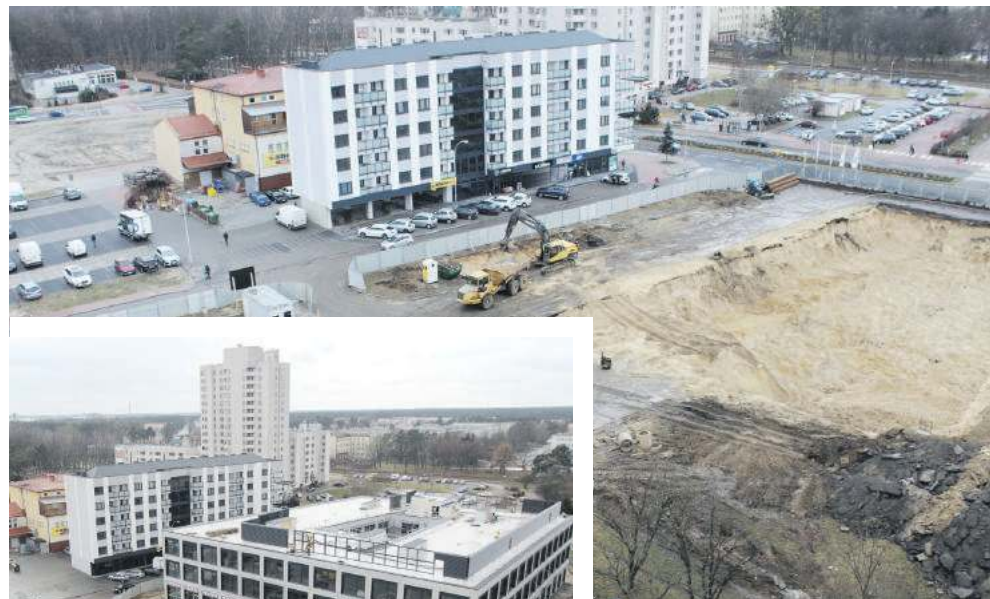
To samo miejsce po upływie roku. Powyżej plac budowy biurowca sfotografowany 8 lutego 2022 r. Z lewej – stan z 13 lutego 2023 r. Prace przebiegały bardzo sprawnie – był czas, że na placu budowy operowały dwa dźwigi
