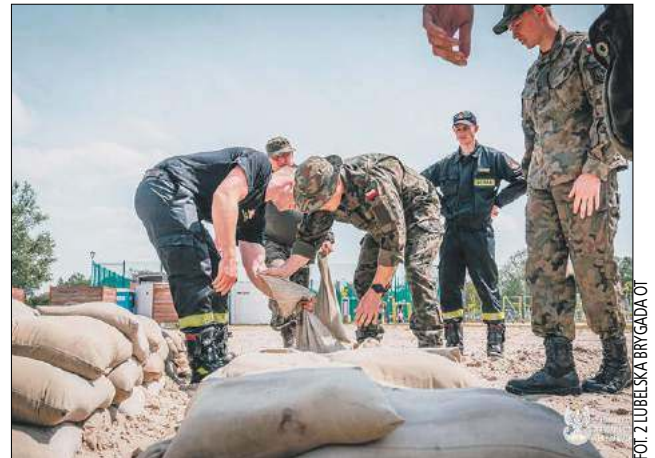
Żołnierze poznali też zasady budowania wałów przeciwpowodziowych
