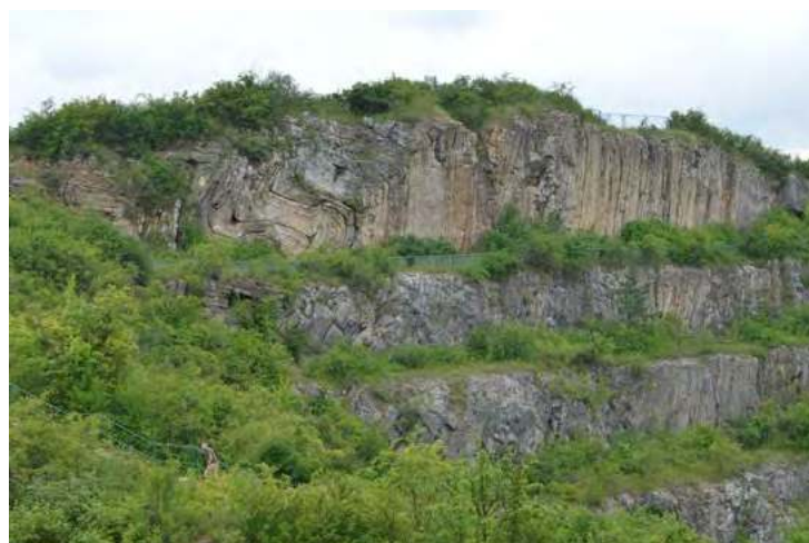
Fot. 3. Ściana wschodnia kamieniołomu zachodniego na Ślichowicy (A. Kasprzyk)
