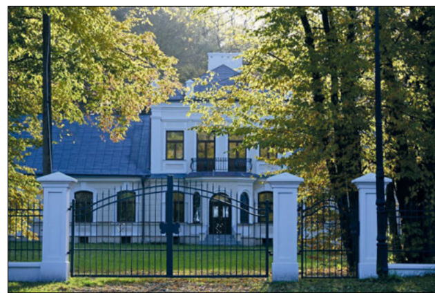
Prace rewitalizacyjne w zespole dworsko-pałacowym w Wilczynie potrwać sześć miesięcy
