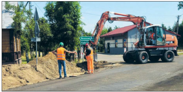
Modernizowany odcinek kosztować będzie 13 361 265,09 zł, z czego 4 008 379,53 zł stanowi wkład własny powiatu i gminy Kąkolewnica, a 9 352 885,56 zł to dofinansowanie z Rządowego Funduszu Rozwoju Dróg
