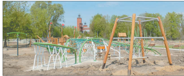
Prace przy budowie Bulwarów nad Tocznią postępują zgodnie z harmonogramem
