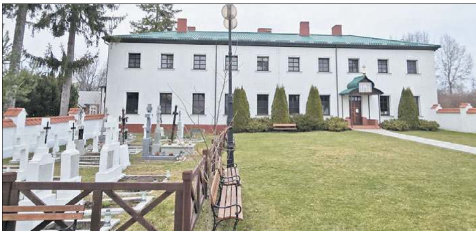
Dach na budynku klasztoru wymaga natychmiastowego remontu
