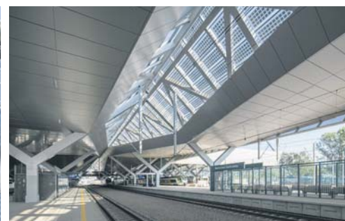
Dworzec Zachodni w Warszawie - zadaszenie BIPV od ML System o mocy 1,1 MWp
