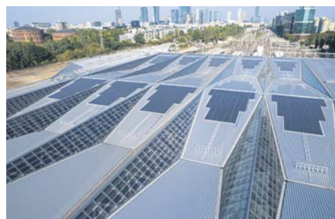
Dworzec Zachodni w Warszawie - zadaszenie BIPV od ML System o mocy 1,1 MWp
