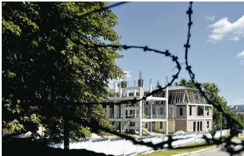
• Budowa Domu Polskiego we Lwowie trwa już ponad dekadę. MSZ od 2020 r. do 2024 r. przekazywał pieniądze na utrzymanie wstrzymanej budowy. Teraz chce je odzyskać
