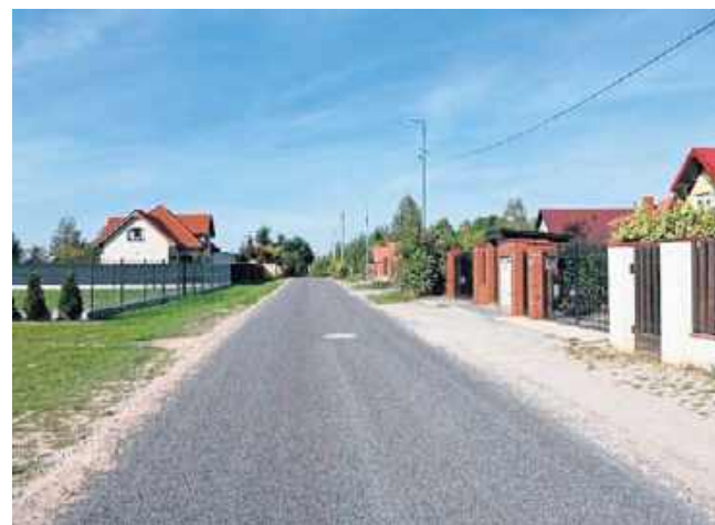
Zakończyła się przebudowa ulicy Podmasłowie w Woli Kopcowej w gminie Masłów
