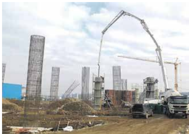
Filary węzła Nowy Targ Południe już powstają.
