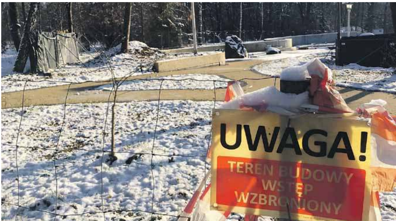
Roboty stanęły na wiosnę.
