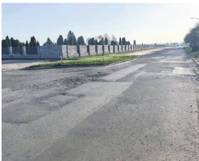
Projekt obejmuje budowę i przebudowę ulic.
