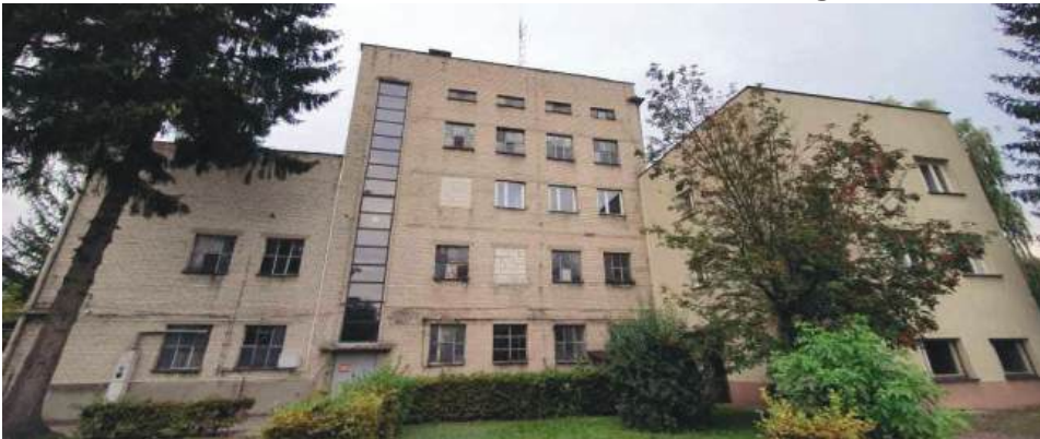
Miejska ciepłownia w Hrubieszowie jest już w pełni przygotowana do rozpoczęcia nadchodzącego sezonu grzewczego. Ciepła nie zabraknie. Pytanie, ile za nie zapłacimy?
