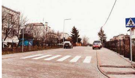
Nowe ulice wyremontowano dzięki FDS
