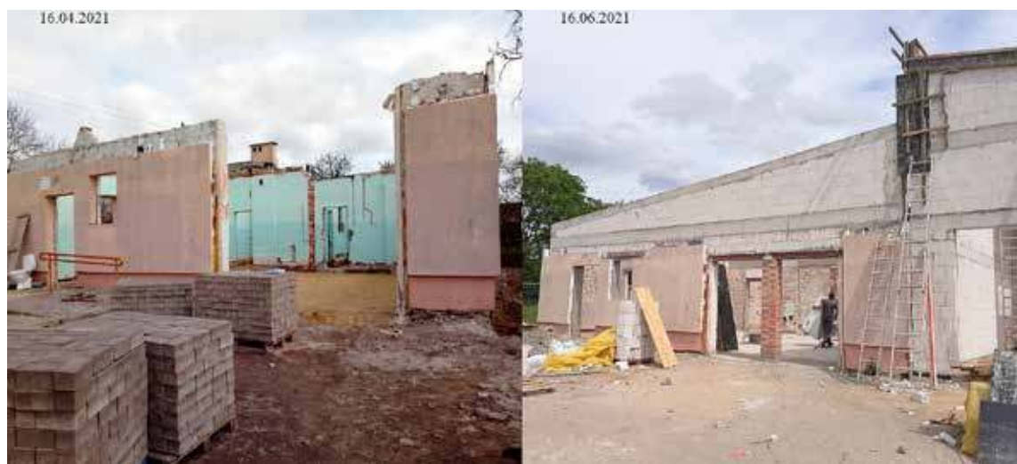
Zaawansowanie robót w Redle według stanu na dzień 16 czerwca 2021 roku. Foto UG Osina
