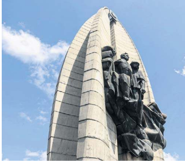
Pomnik wymaga poważnego remontu
