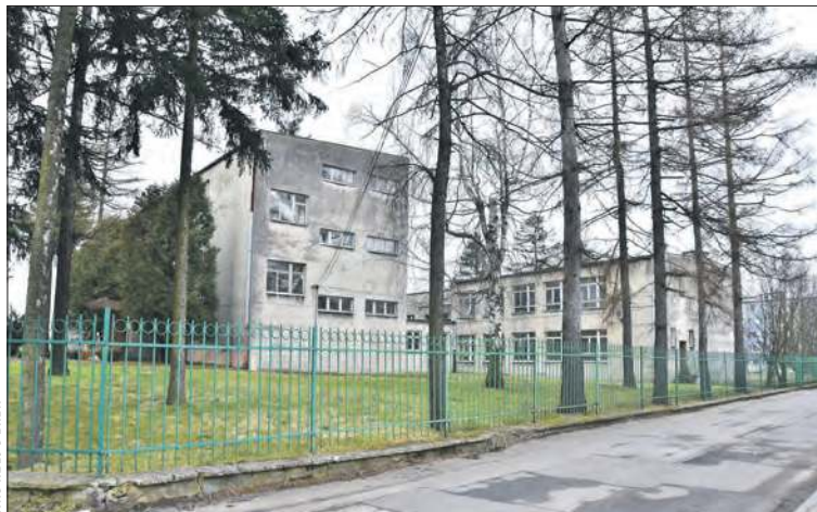
Powiat proponuje poznańskiej fundacji budynek byłej szkoły przy ul. Podgórnej
