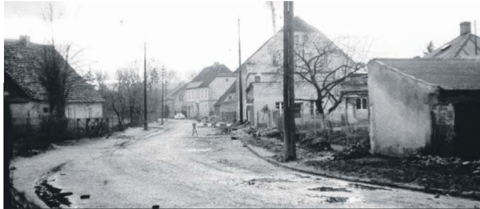
Zdjęcie nr 1 zrobiłem w 1967 - to ulica Lumumby, wcześniej Ogródowa, dziś Armii Krajowej. Po lewej budynek mieszkalny, który dziś nie istnieje - w tym miejscu dziś mamy ulicę 11 Listopada. Po prawej stoi komórka, która dziś nie istnieje. Dalej wjazd do Warsztatów Szkoły Zawodowej, powszechnie nazywanej „żubrówką”. Następny duży budynek to było przedszkole. Pozostałe budynki widoczne w głębi już nie istnieją. Na końcu widocznej ulicy jest zakręt, a dalej po prawej stronie znajduje się Szkoła Podstawowa nr 1
