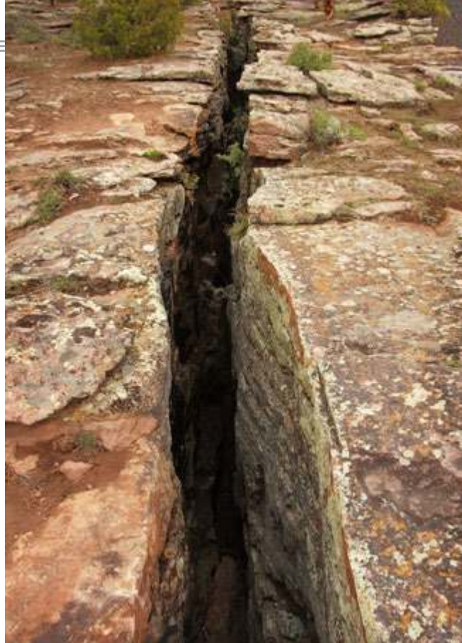
Pęknięcia skalne, fot. Dreamstime
