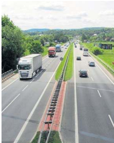
Drogi wzdłuż zakopianki będą modernizowane
