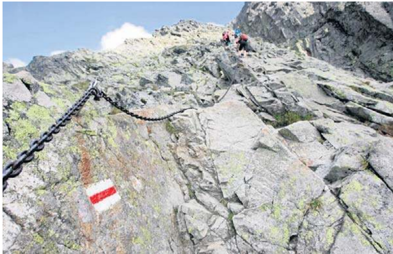
W ramach prac wymienione zostaną łańcuchy asekuracyjne
