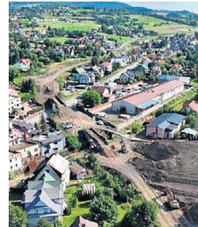
W przyszłym roku pojadą tędy pociągi
