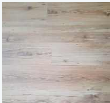
🔗 Panele winylowe ułożono na gładkiej wylewce anhydrytowej.
