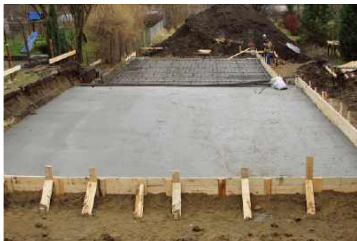
🔗 Płyta fundamentowa ze świeżo wylaną warstwą betonu, który należy pielęgnować przez polewanie wodą. T. RYBARCZYK
