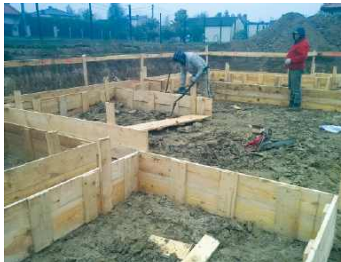
U Wykonywanie fundamentów zimą jest możliwe, pod warunkiem zabezpieczenia masy betonowej przed zamarznięciem w początkowej fazie wiązania oraz zapewnienia warunków do prawidłowego jej dojrzewania. T. RYBARCZYK
