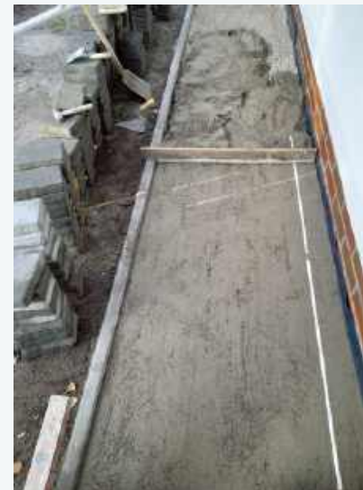
Etap formowania mieszanki piasku z cementem (szablonem wzdłuż prętów).
