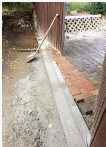
➡ Na krańcach wykopu osadzono solidne obrzeża z betonu.
