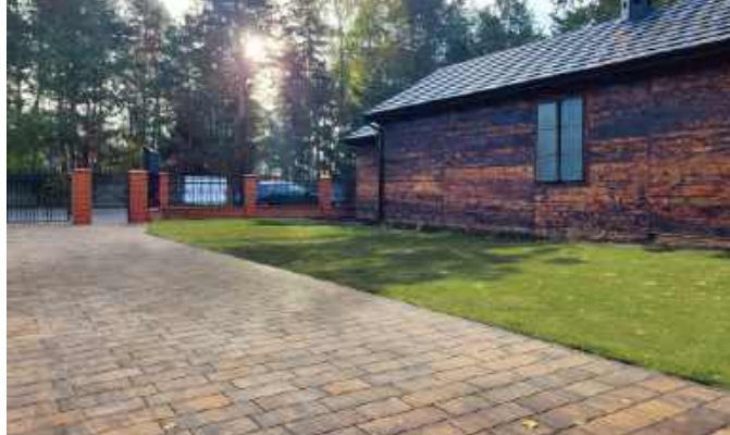
🔧 Podjazd wykonany z płyt w odcieniach brązu, w trzech prostokątnych formatach z mikrofazą, wpisanych w moduł 90 cm. FORBET
