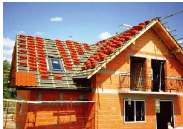
📌 Dachówki ceramiczne na ogół układa się na łątach i kontrłatach, zaczyna się od okapu. RÖBEN
