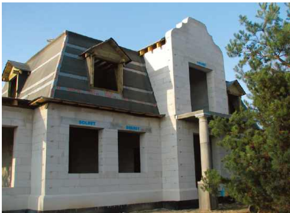
📍 Beton komórkowy ma dobre właściwości termoizolacyjne ale równocześnie jest wystarczająco mocny i trwały, żeby wznosić z niego ściany konstrukcyjne. SOLBET
