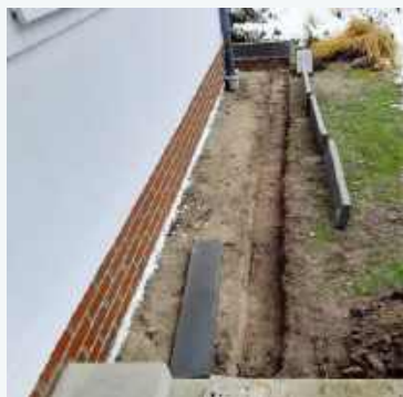
🔧 Etap osadzania obrzeży na chudym betonie, na krawędzi wykopu.
