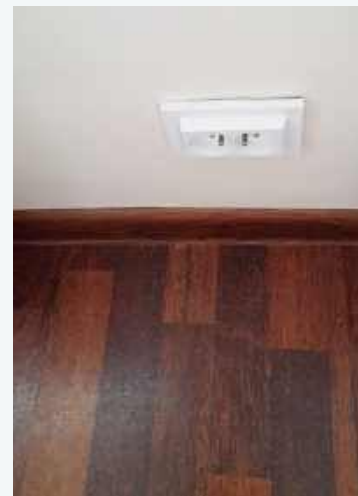
🔧 Wokół posadzki pływającej (na macie wygłuszającej), przytwierdzone niskie listwy.
