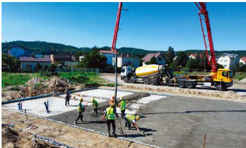
❶ Płytę fundamentową warto wybrać wtedy, gdy grunt na działce ma słabą nośność lub jest niestabilny. PARATI
