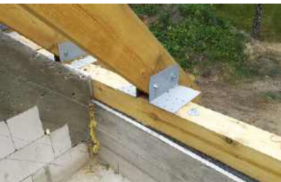
📌 Łączniki ciesielskie do zamocowania krokwi na murfacie. T. RYBARCZYK
