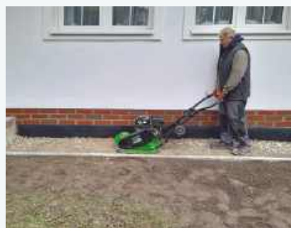
Etap maszynowego zagęszczania kruszywa.
