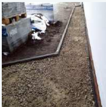
🔧 Wzdłuż ściany, ułożono pas folii, na dnie wykopu – tłuczeń.
