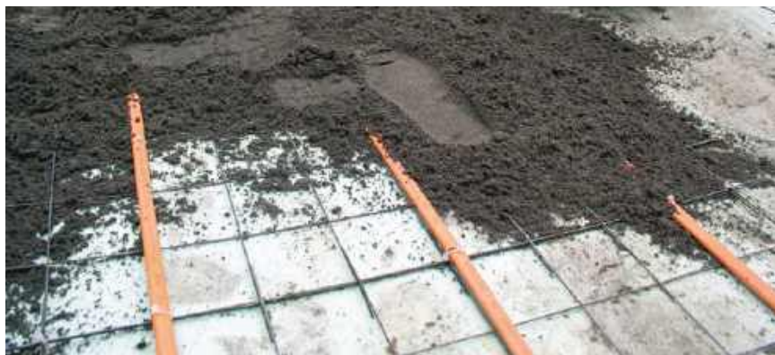
🔧 Kable grzejne montowane w podsypce pod kostką brukową lub płytami można dowolnie docinać na wymiar, co ułatwia ich dopasowanie do każdej nawierzchni. RAYCHEM
