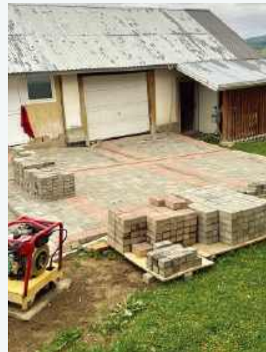
❶ Przed garażem, ułożono głównie kostkę szarą o grubości 6 cm (czerwona 8 cm).
