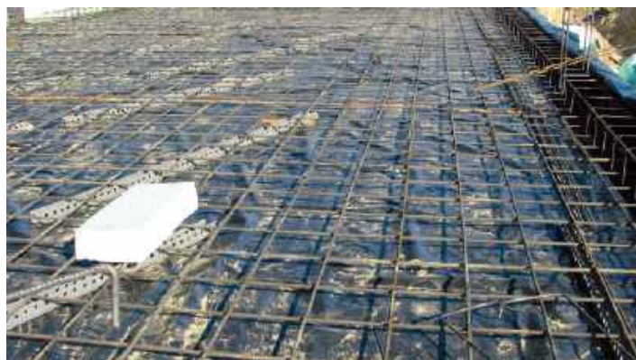
🔗 Ułożenie zbrojenia zapewnia odpowiednią wytrzymałość płyty fundamentowej przez precyzyjne rozmieszczenie prętów zbrojeniowych. T. RYBARCZYK
