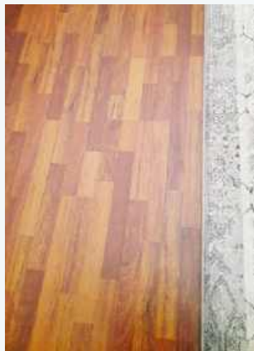
🔧 Laminowane panele zastosowano na piętrze, montaż wykonano samodzielnie.
