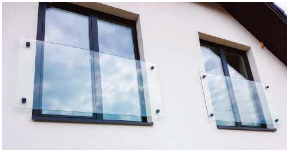
🔧 Montaż balustrady do ściany budynku to popularna i sprawdzona metoda zabezpieczania dużych przeszkleń. KOSSGLASS
