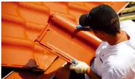
🔧 Zwykle mocuje się tylko co piątą dachówkę oraz wszystkie dachówki skrajne. RÖBEN
