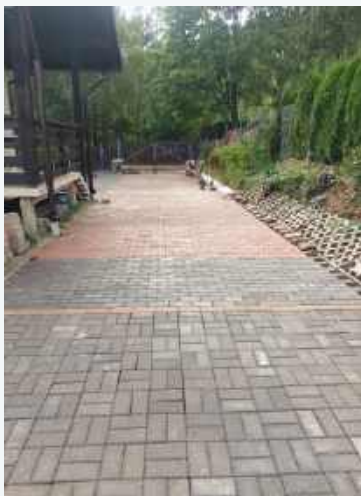
➡ Nawierzchni nadano spadek, pod nią – drewno, kruszywo rozmaitej frakcji.
