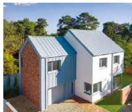
🔧 Arkusze blachy płaskiej mogą mieć formę paneli z fabrycznie uformowanym rąbkem. Elementy łączy się przez dociśnięcie sąsiadujących rąbków, mniejszego z większym. BLACHY PRUSZYŃSKI
