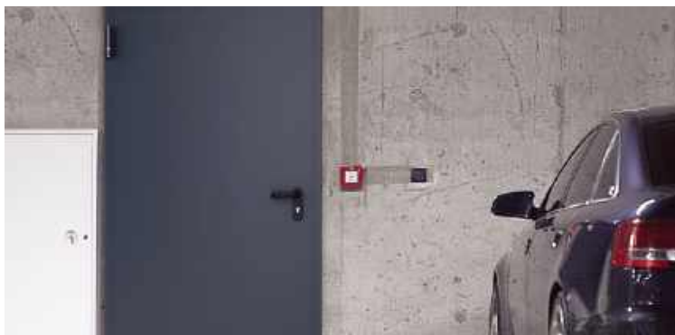
Drzwi z garażu do części mieszkalnej powinny być szczelne, ciepłe i odporne na ogień. LEROY MERLIN
