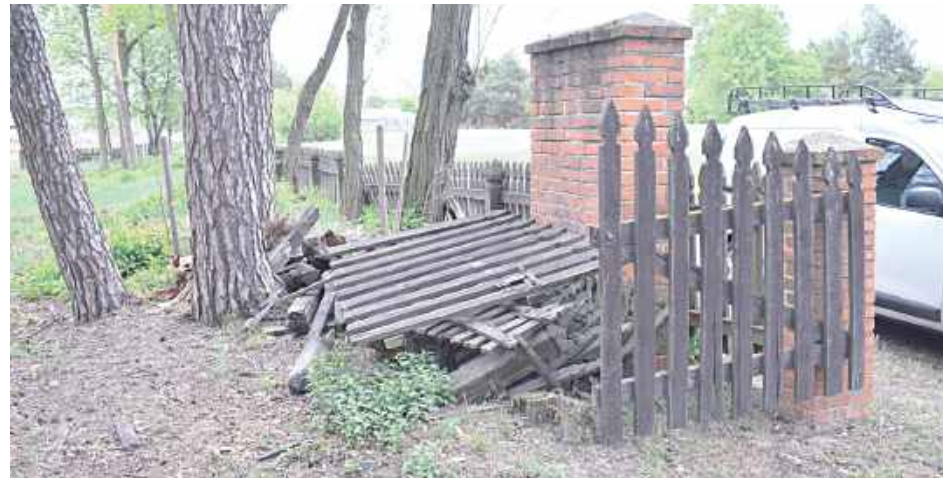
Uwagę zwraca rozwalone ogrodzenie cmentarza
