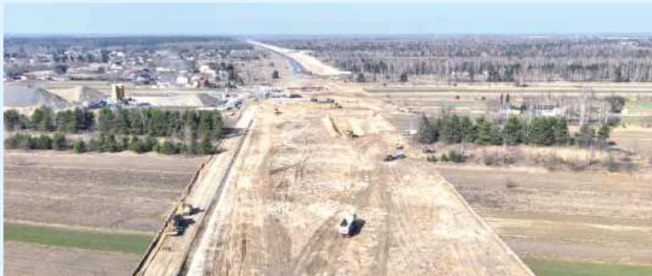
Jeszcze w tym roku rozpocznie się budowa nowych odcinków ekspresówek, które prowadzą do Zamościa
