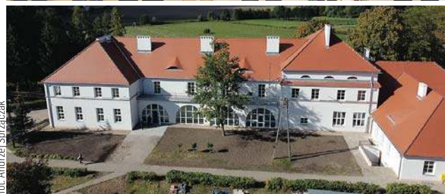
Termomodernizacja budynku dydaktycznego przy Zespole Szkół im. Emilii Sukertowej – Biedrawiny w Malinowie
