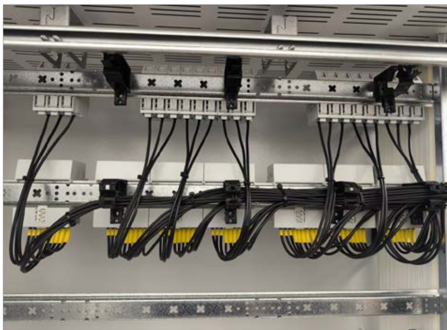
Fot. 2. Przykład ułożenia w powietrzu i wiązkach (zdjęcie wykonane od strony „pleców” rozdzielni)
