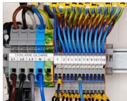
Fot. 1. Wszystkie wersje złączek zapewniają również możliwość mostkowania
