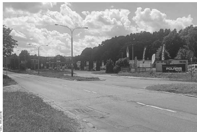
Wjazd do Olsztyna od strony Warszawy zostanie przebudowany
