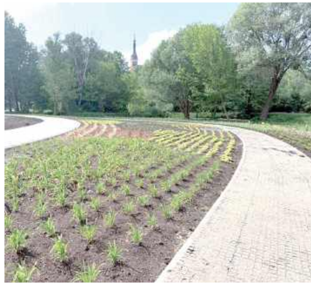
W ramach inwestycji powstają ścieżki, które połączą plac targowy z placem maryjnym i sanktuarium. A wszystko ma być otoczone zielenią
