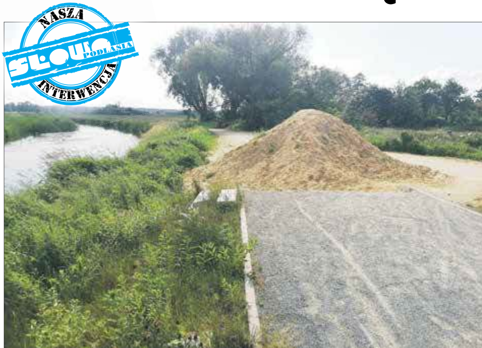
Równo miesiąc przed terminem, wyznaczonym na zakończenie prac, związanych z budową ścieżki rowerowej wzdłuż Krzny, przedsięwzięcie wygląda tak (widok na wysokości ul. Żurawiej)
