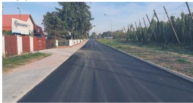
Przebudowa ul. Granicznej w Krasnymstawie
