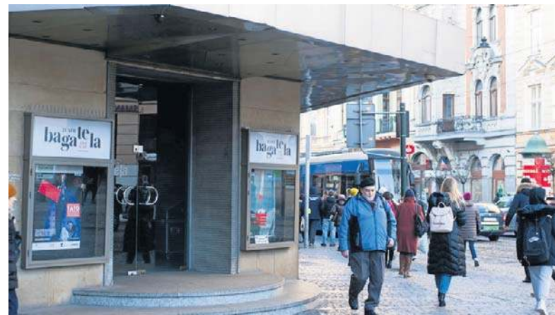
Teatr Bagatela czeka gruntowny remont i przebudowa
