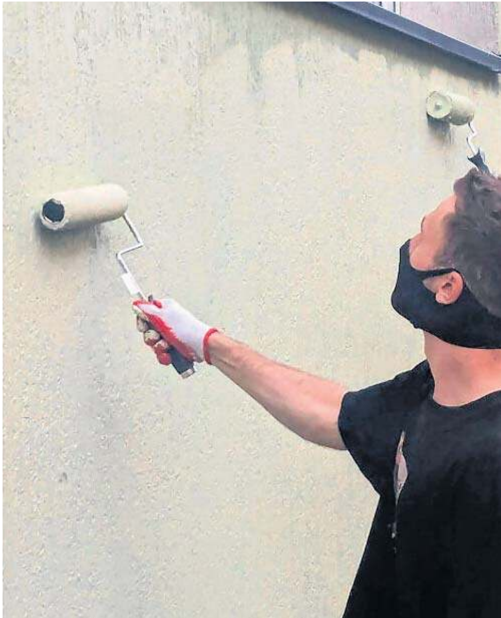
FOT. ARCHIUM PEYOWITNE GUM-Y
