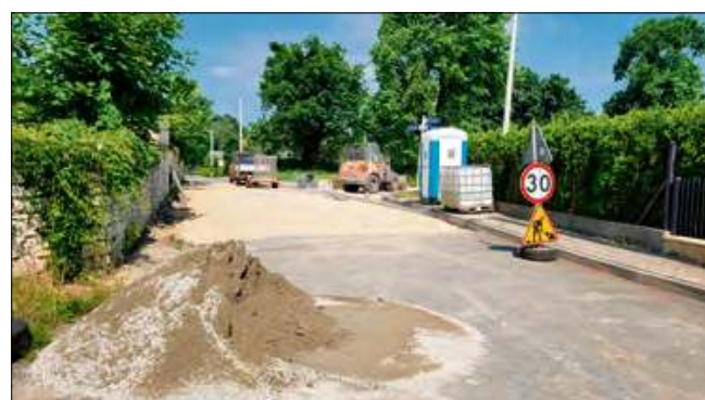
Prace budowlane w Choruli idą pełną parą.
