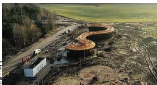
Trwa budowa dużej tężni solankowej w kształcie ślimaka
