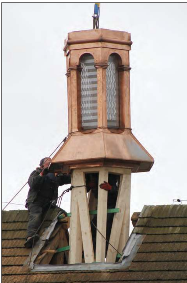
Remont przypadł na okres zimowy. Na szczęście aura jest przychylna. Piotr Miścis z Przedsiębiorstwa Wielobranżowego z Krasnegostawu, które jest podwykonawcą robót. - Samo „założenie” wieży na przygotowanej konstrukcji może nie było takie trudne, ale później odczepienie lin już takie łatwe nie było. Mamy ponad 20-letnie doświadczenie w pracach przy kościołach zabytkowych, więc nie baliśmy się tego wyzwania - podkreśla pan Piotr.
