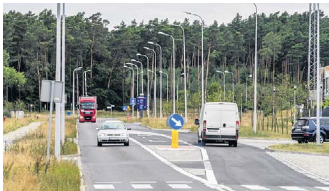
Koszt inwestycji to niespełna 1,2 mln zł. Nowa trasa powstanie na odcinku o długości 0,5 km
