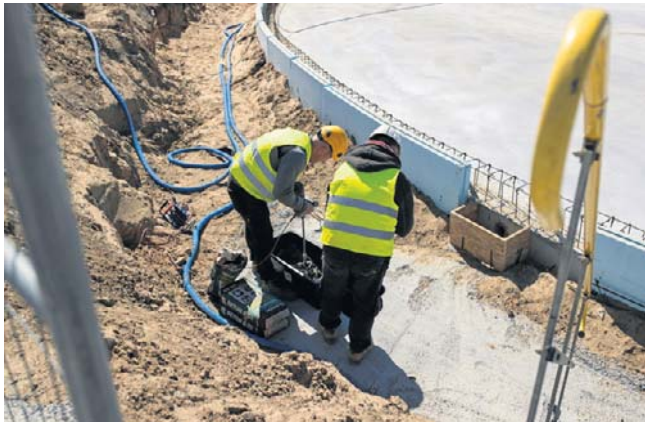
Początek budowy biogazowni spółki ProNatura - kwiecień 2026
