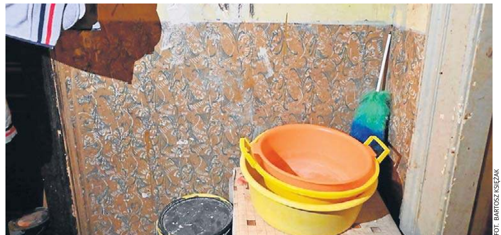
Myć się trzeba w misce. Takie „luksusy” w komunalnej kamienicy przy reprezentacyjnej ulicy Łodzi.
