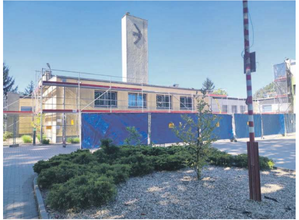
Trwają prace związane z rozbudową Publicznej Szkoły Podstawowej nr 1
