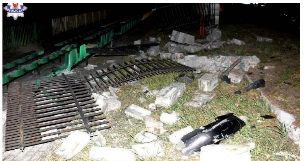
Siła uderzenia była tak duża, że auto uszkodziło metalowe przesłania i betonowe elementy płotu (fot.KPP Łuków)
