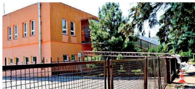
W siedzibie GDDKiA została również uszkodzona metalowa konstrukcja budynku
