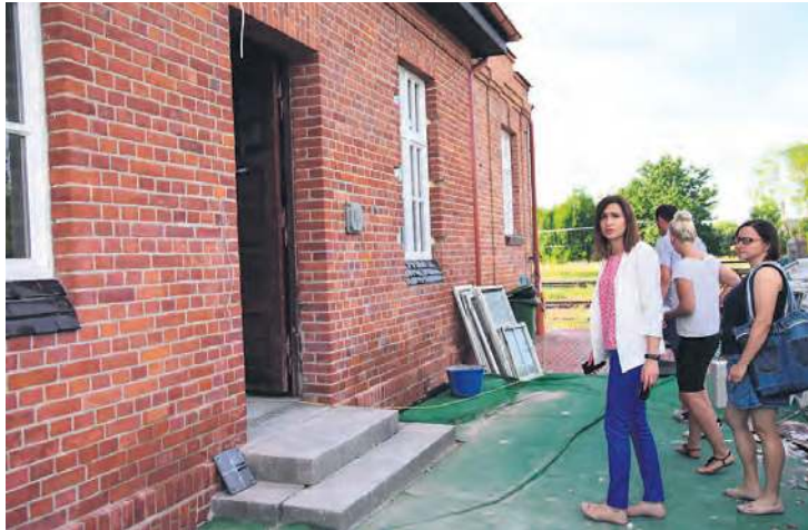
Wejście od prawej strony budynku dworca. Tutaj część pomieszczeń zostanie wydzielona na potrzeby PKP.
