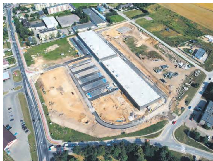
Tuchola Park – tak wyglądał zakres prac 24 lipca 2021 r. Otwarcie galerii zaplanowano na 14 października. Fot. (Iz)
