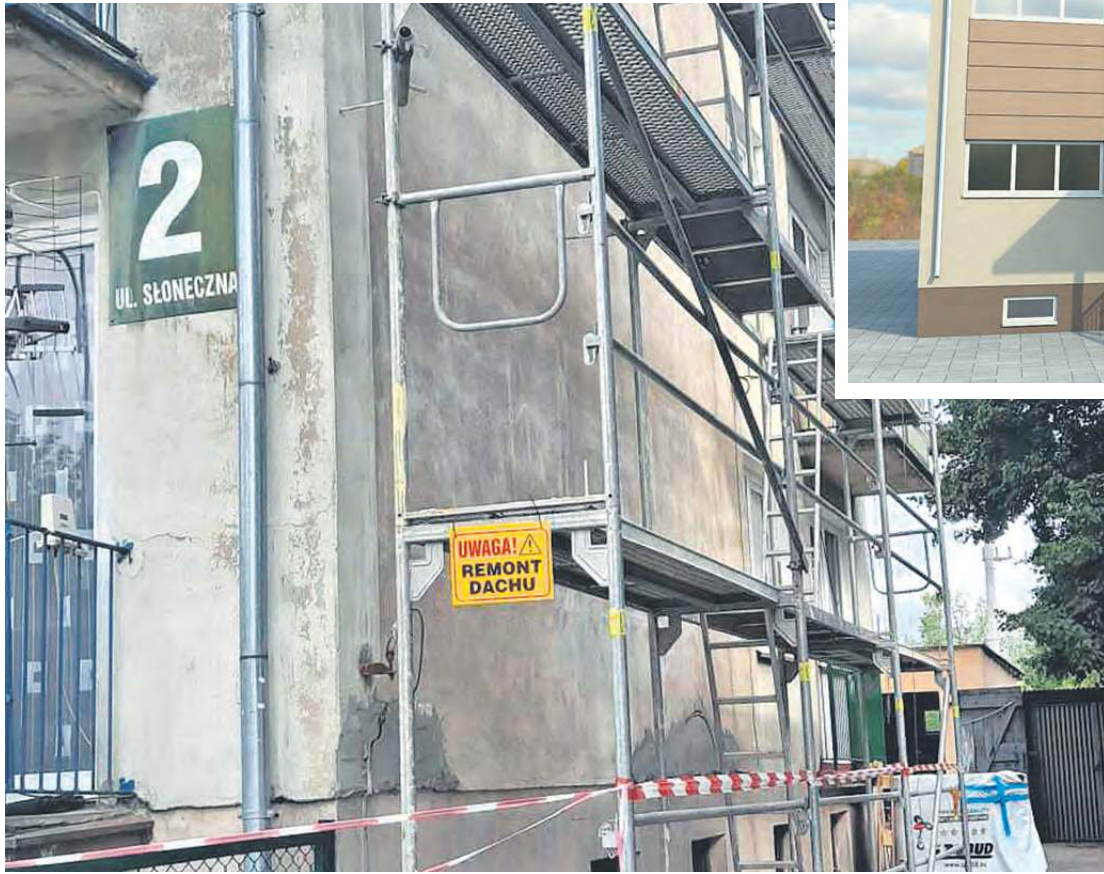
Prace przy ul. Słonecznej 2 już się rozpoczęły.
