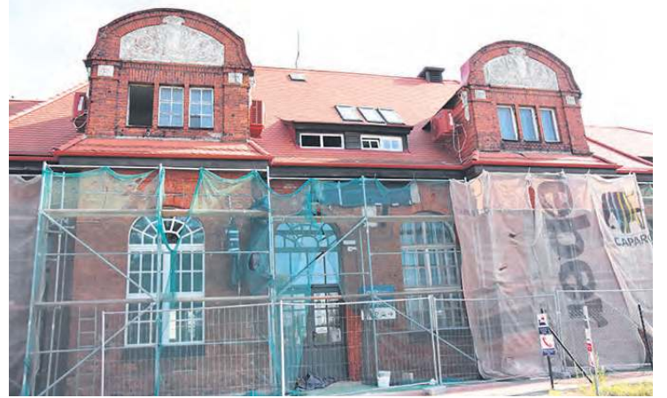
Tył dworca i trwające obecnie prace w zakresie odnowienia elewacji.
