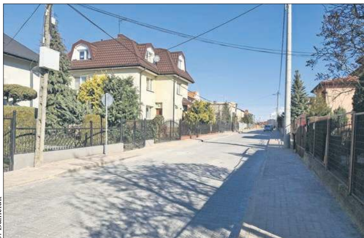
Ulica Mała po przebudowie
